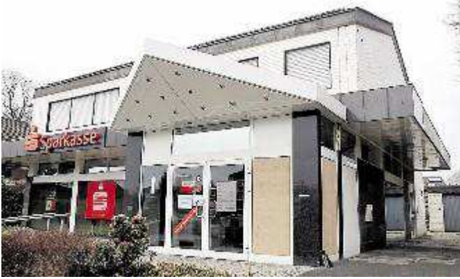
Am Standort der Sparkassenfiliale in Sythen ist ein Neubau geplant. Wolter
