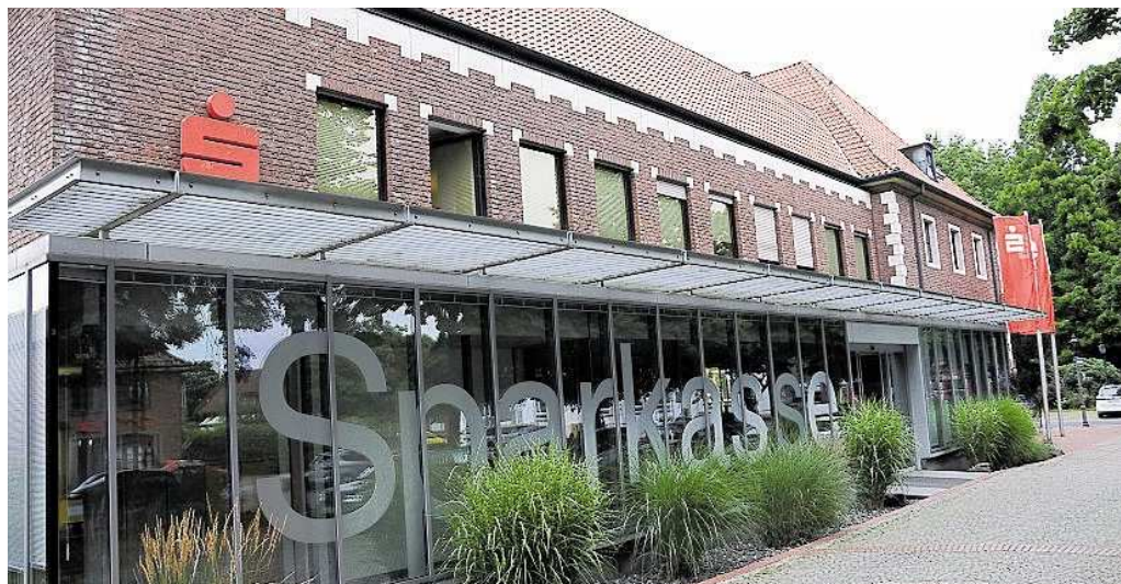
Die Hauptstelle der Sparkasse an der Koeppstraße in Haltern wird umgebaut. Kindel
